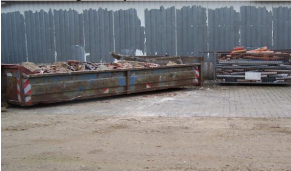
Byggeaffald til venstre og kloakaffald (PVC?) til højre
