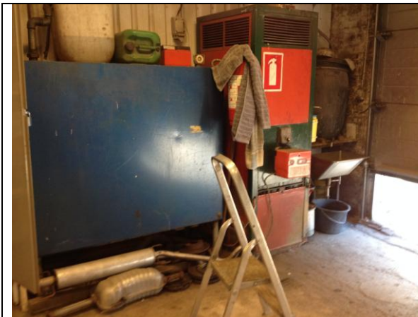
Foto 1 af overjordisk olietank til oliefyr
