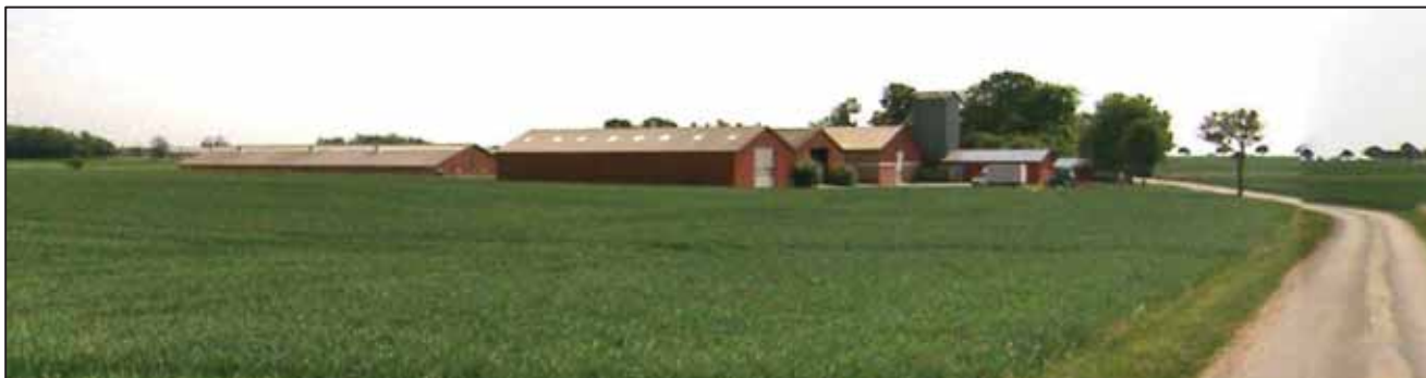
Foto 2. Langemyregård set fra nord fra Trassevejen (retning mod Grammegårdsvejen). Kilde: Cowi vejfoto1. juni 2018.
