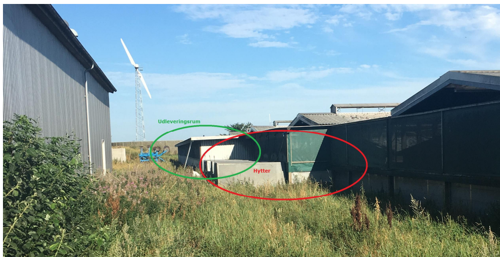
Figur 2: Hytter og udleveringsrum set udefra
