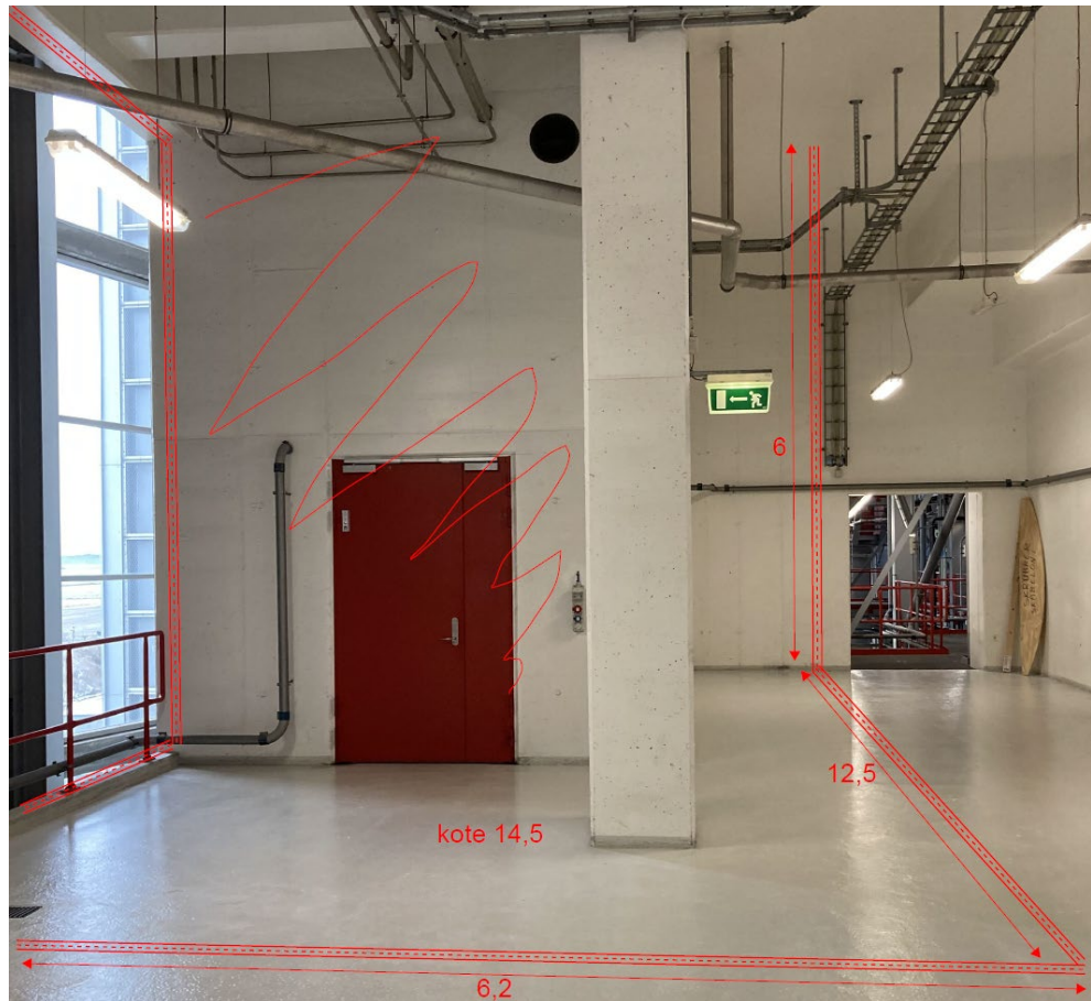
Figur 1: Den nye varmepumpe etableres i det røde område angivet i figuren. Det skraverede rum med døren er den eksisterende støvsugercentral, der flyttes. Væggene nedbrydes for at gøre plads til varmepumpen.
