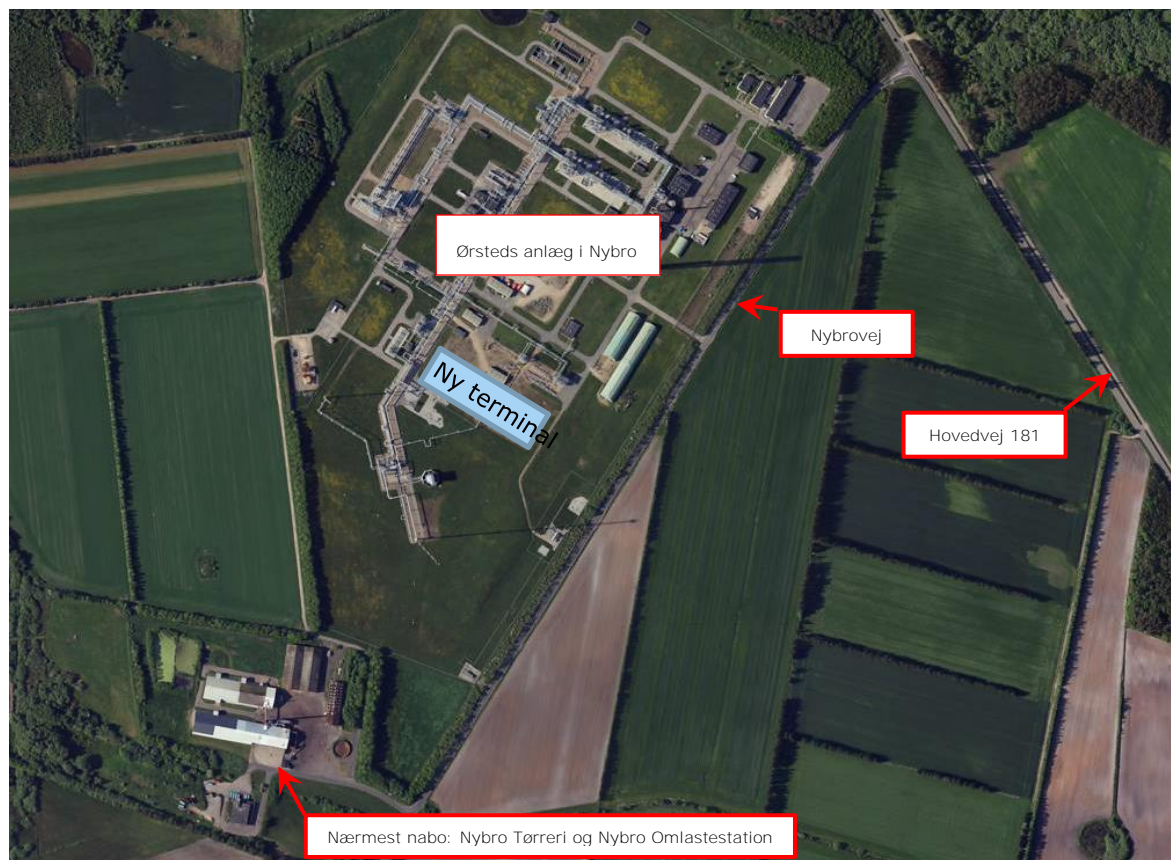
Figur 1-1 Baltic Pipe terminal inden for det eksisterende hegn omkring Ørsteds anlæg.
