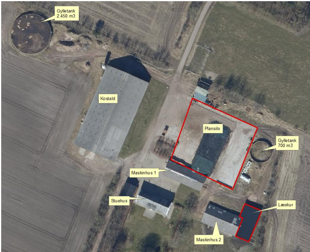
Figur 3. Oversigt over husdyrbrugets bygninger.
