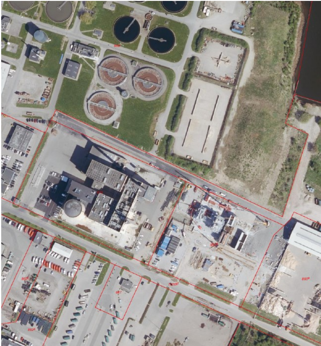
Luftfoto af Fjernvarme Horsens, kraftvarmeværk – affaldsforbrænding og gasturbine til venstre, byggeplads til nyt biomasseværk til højre. Matrikler er angivet med røde streger.
