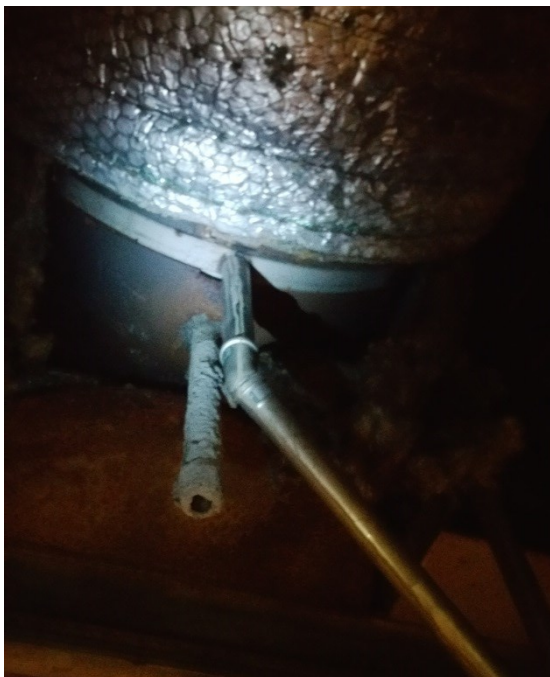
Nyt dræn i skorsten. Etableret i august 2017.
