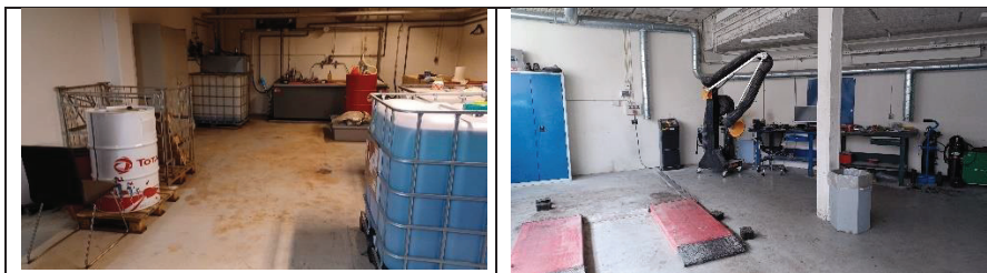
Olietank samt andre råvarer + nedlagt pladeværksted
