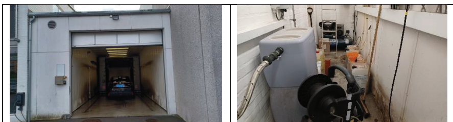
Vaskehal samt teknikrum.
