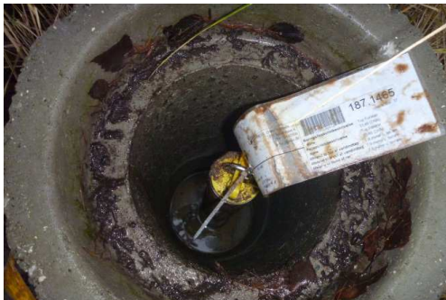
Fig. 4 De øvrige besigtigede boringer var alle forsynet med prop, lås og mærkat.
