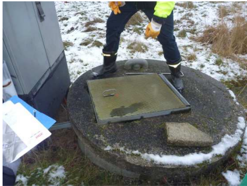
Fig. 2 Perkolatbrønd og målerskab
