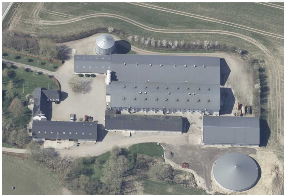
Figur 1 Anlæg set fra øst – forrest til højre ligger gødningshuset. Ny Gylletank er beliggende nederst i billede.
