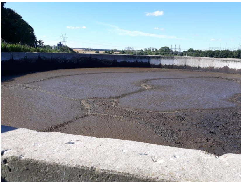
Gyllebeholder: Den mindste gyllebeholder var uden fast eller tæt overdækning.
