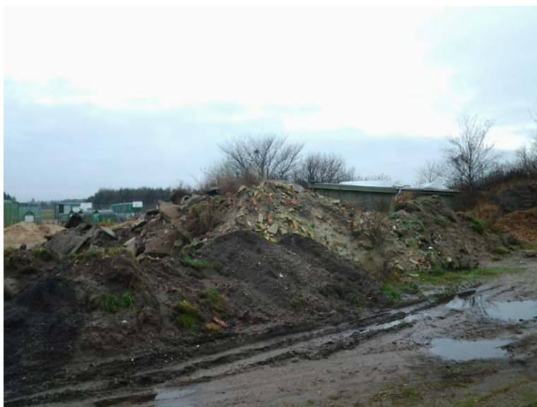
Jord, beton og mursten i blandet jord/sand.
