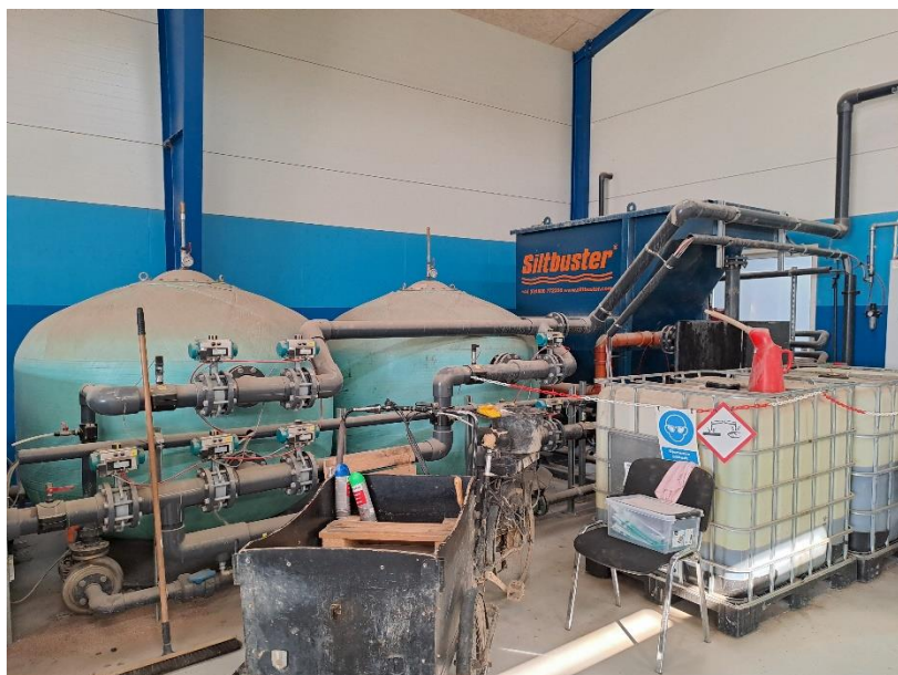
Figur 9: anlæg til rensning af spildevand
