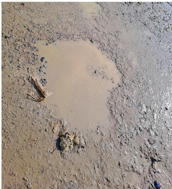
Figur 7: større ujævnhed i belægningen
