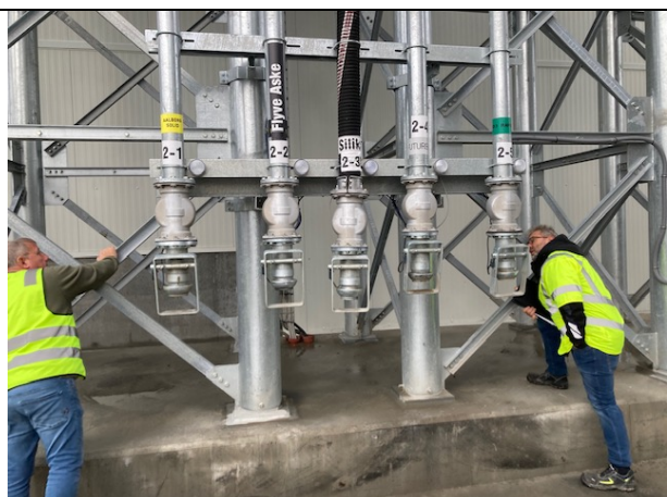
Foto 20 Påfyldningssted for siloerne.
