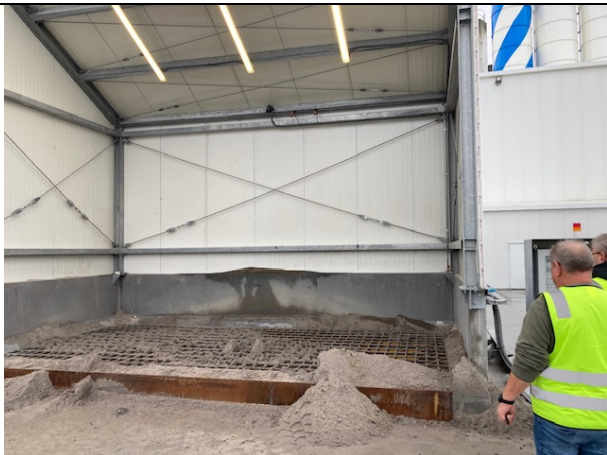
Foto 17 Plads til aflæsning af materialer til ny fabrik.
