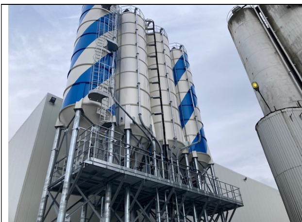
Foto 19 Siloerne til den nye fabrik
