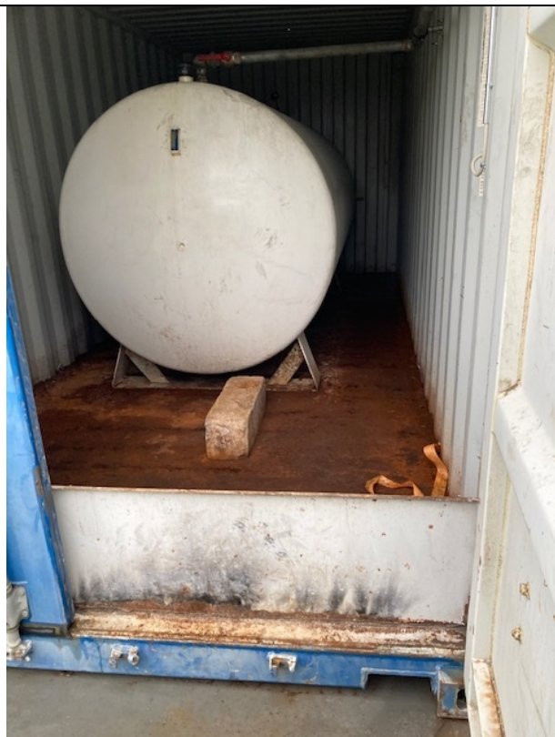
Foto 11 Tankens placering i container med opkant.
