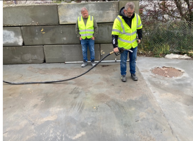
Foto 10 Pistolen er for lang, da den ikke er 1/2 meter kortere end påfyldningspladsen.
