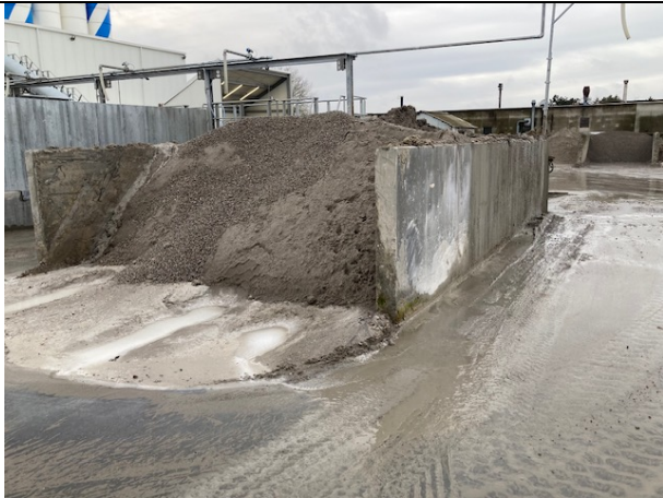
Foto 15 Plads til afvanding af bundfald fra bassin se foto 14.
