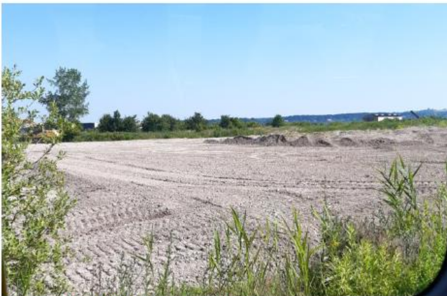
Figur 4 Dele af etape F, hvor der ikke forventes at blive deponeret mere asbest.
