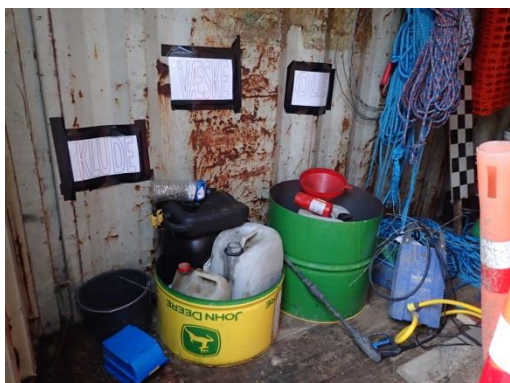
Billede nr. 5: Opbevaring af farligt affald i miljøcontainer.
