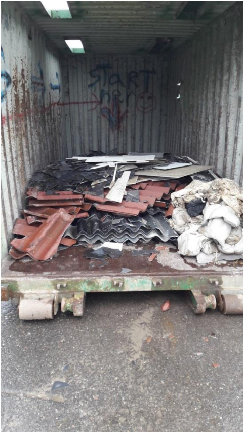
Figur 6 Opbevaring af knuste asbestplader i delvis åben container.
