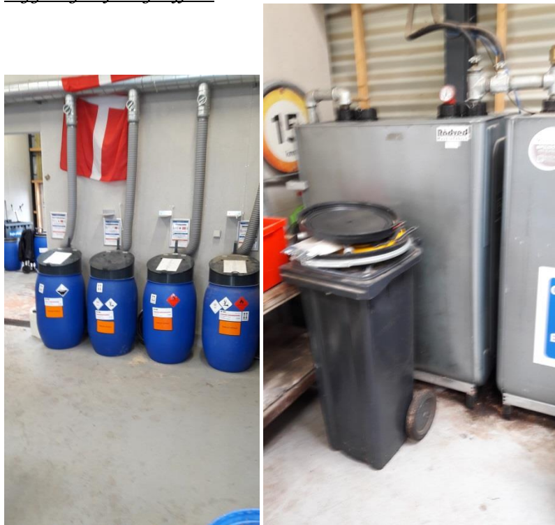
Figur 9 beholdere til forskellige fraktioner af farligt affald i bygningen til farligt affald. Der er udsug fra den enkelte beholder. Afkastet er ført over tagryg. Til højre er billede af tanke til spildolie.
