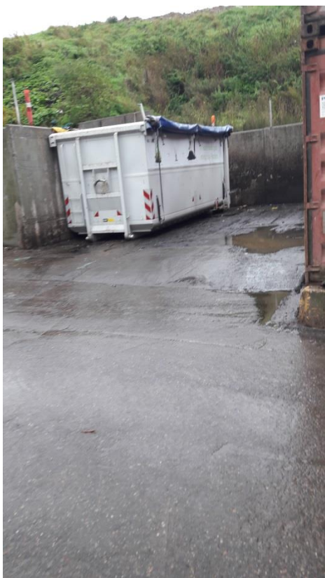
Figur 24 Omlastepladsen til organisk husholdningsaffald, hvor containeren står åben, hvilket den gjorde under hele tilsynet. Pladsen står under vand, da belægningen er beskadiget og der er spild af husholdningsaffald bag ved den røde container i højre hjørne.
