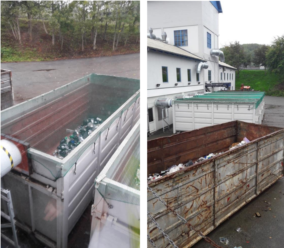
Figur 20 tv. Container, hvor glasaffald blæses ud i. th. oversigt over de forskellige containere, hvor de sorterede fraktioner blæses ud i. Der er net over alle containerne. Udsugningsanlæggene på bygningen er også blevet støjdæmpet i foråret 2018, hvilket RA vurderer, har reduceret støjbelastningen fra anlægget betragteligt.
