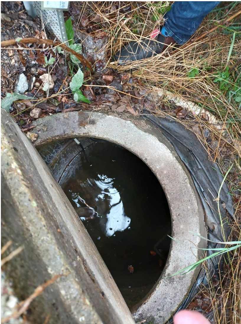
Billede 9 - Boring B1 opstrøms boring placeret sydsydvest for deponiet, hvor der står grundvand op i brønddækslet.
