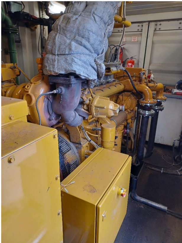
Billede 4 - Inde i container med motoren, der udnytter gassen til strøm til el-nettet
