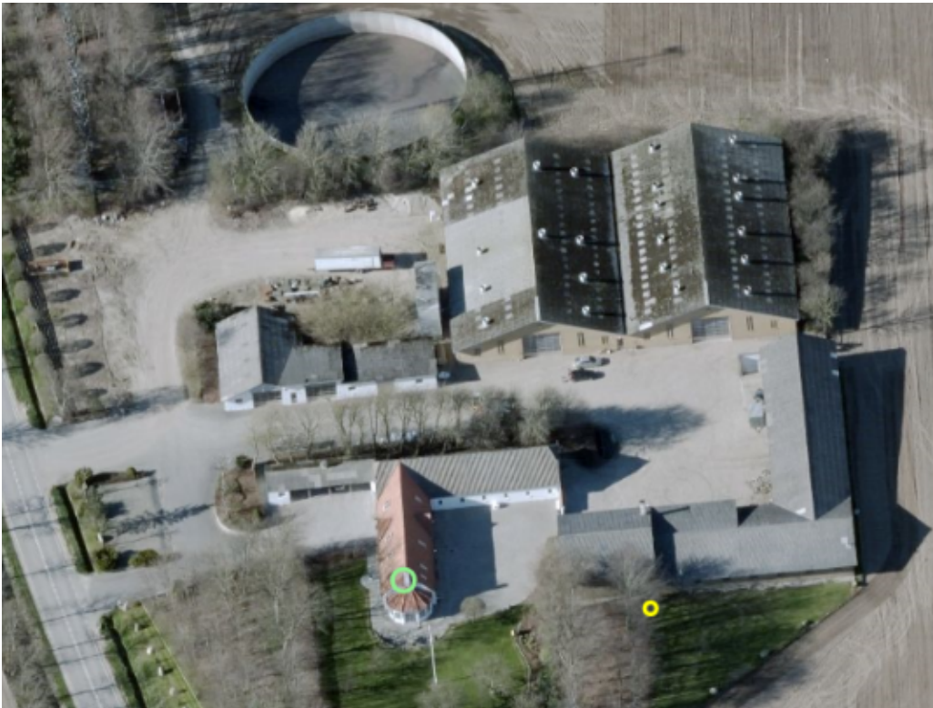
Figur 2: Ejendommen set fra syd
