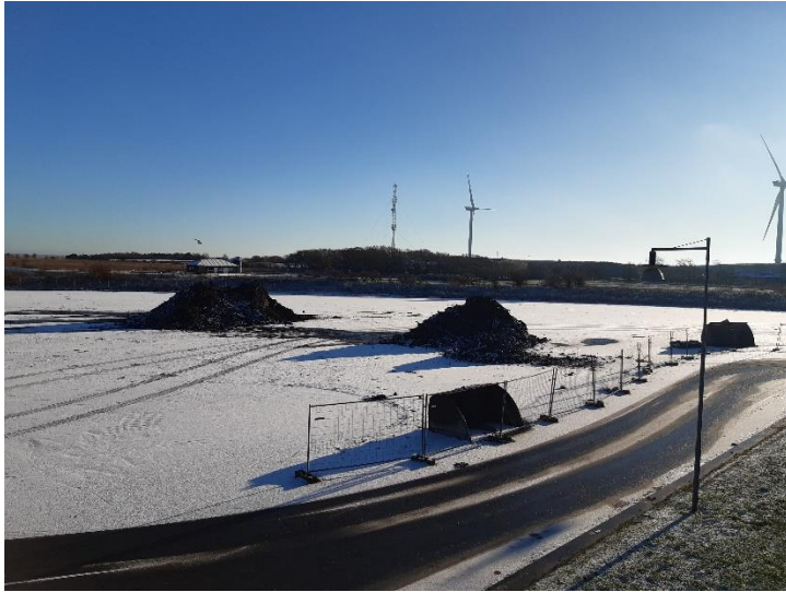
Slaggepladsen, nærmeste bunke skulle til genindfyring da slaggen ikke var tilstrækkeligt udbrændt
