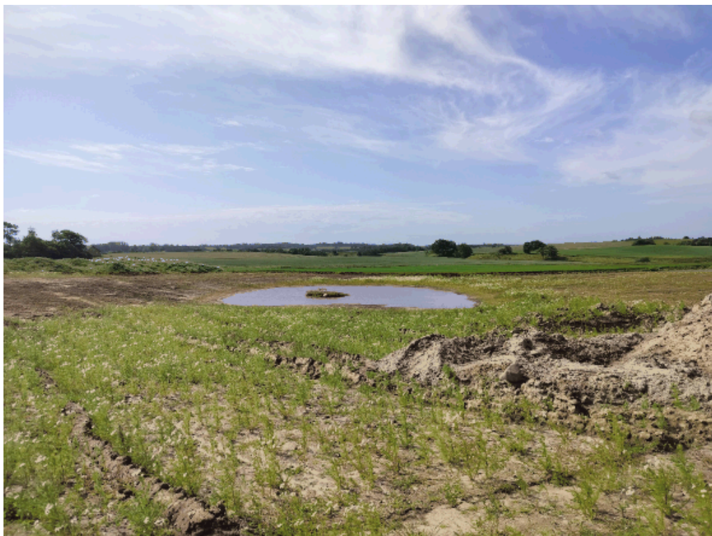
Foto taget fra Hørbylundvej mod syd. Søen udgør det laveste punkt, hvor der skal tilføres mest jord.
