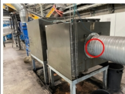
Prøvetagningspunkt før Kulfilter 1.
