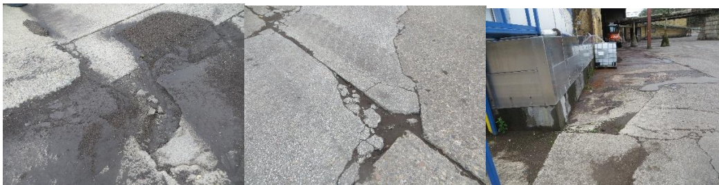
Ovenfor eksempler på kritiske lunger og manglende belægning, hvor vandet søger til, frem for til afløb med opsamling af overfladevand.
