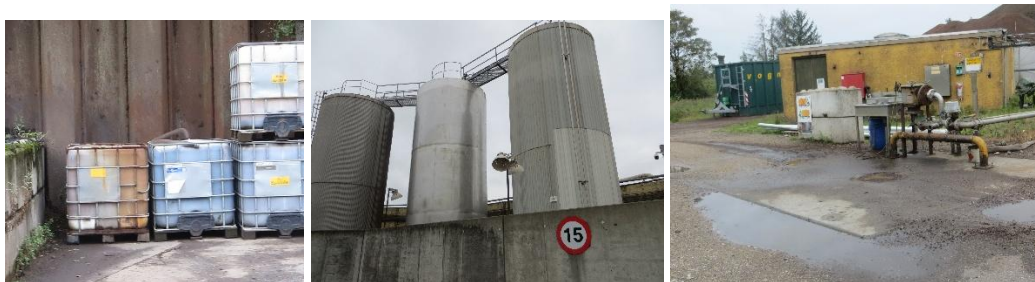
Tv.: To af pallettankene med spildolie er ikke mærket. Midt og th.: Ingen skiltning ved tankningssted og siloer til affaldssprit.
