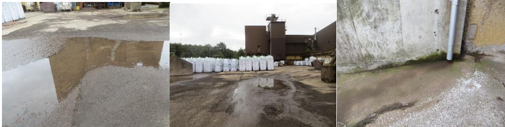
Ovenfor eksempler på opstuvning af overfladevand.
