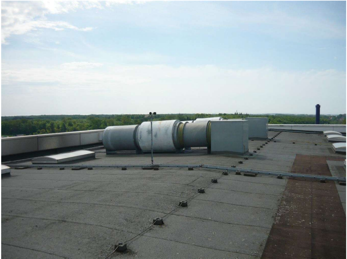
Figur 7: Udsugninger på tag af ovnhal 3. Der findes i alt 4 udsugninger på tagfladen.
