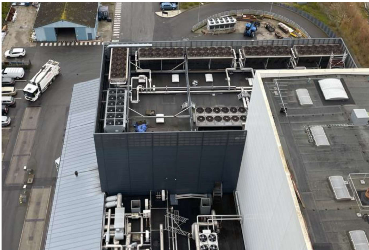
Figur 9-2 Kølere på tag af affaldssilo.
