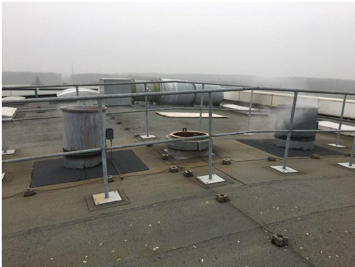
Figur 29: Afbæsning fra opstartsventil over tag (midterste afbæsning)
