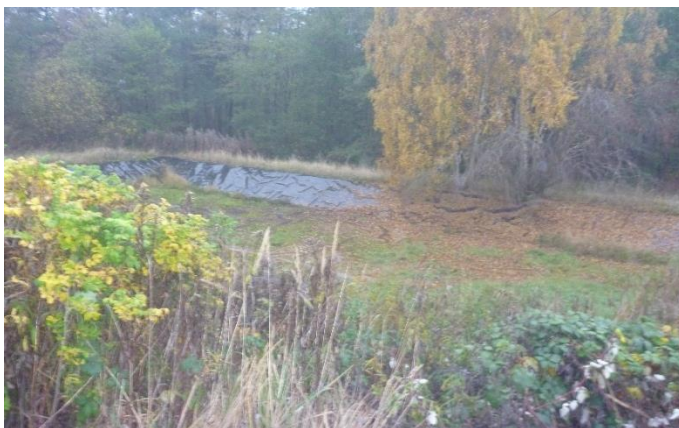
Foto 8: Perkolat overløbsbassinet beliggende ved Uggeløse III.
