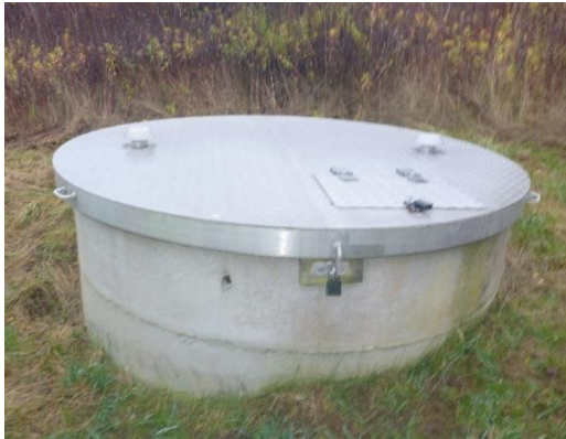
Foto 7 a og b: Perkolatpumpebrønd H, som er beliggende på enhed II.
