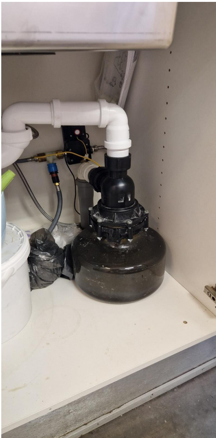
Setlingsbeholder under håndvask til opsamling af ædelmetaller.
