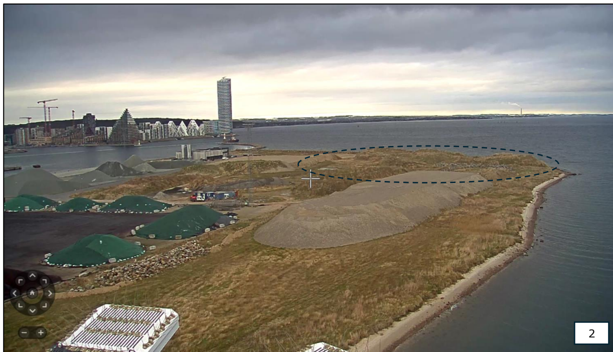
Foto nr. 2 fra oversigtskamera af oliehavnen fra tilsynet 22. november 2024. Det midlertidige jordoplag ses med omtrentlig stiplede markering. Den forreste jordbunke er sand til forbelastning
