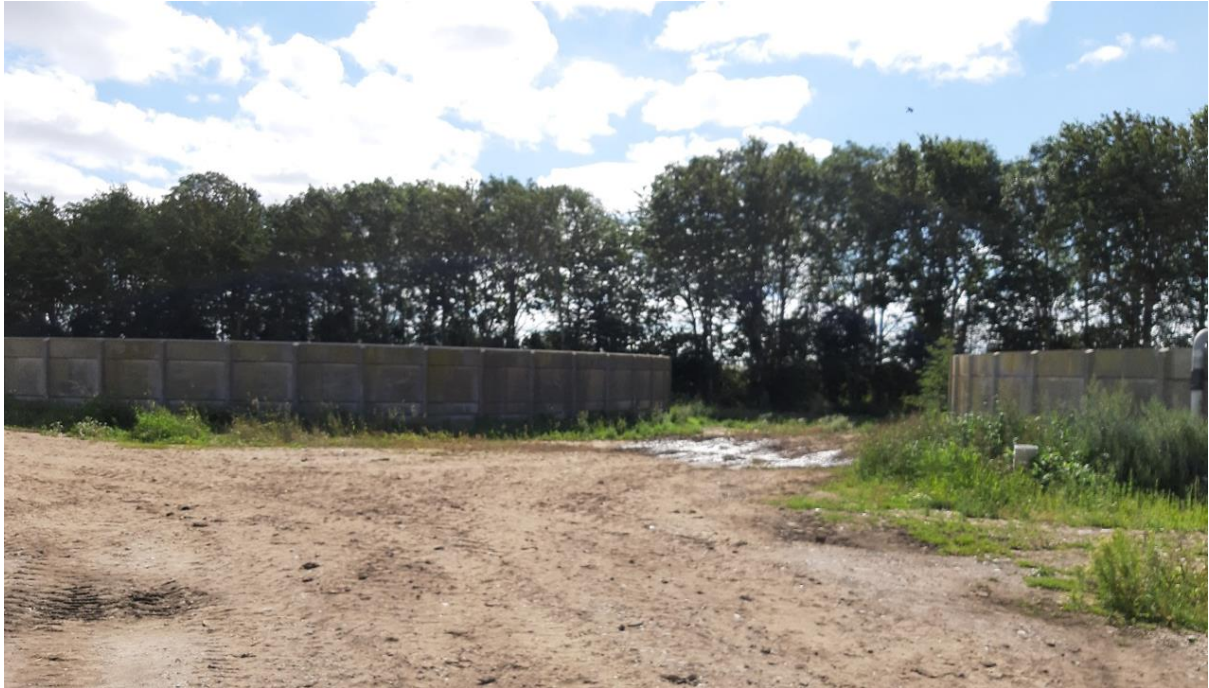
Foto 2. Gyllebeholderene er 2 m over jorden og højden øges til 6,7 m med teltoverdækningen. Den eksisterende læhegsbeplantning er med til at skærme for indsynet, når der etableres teltoverdækning på gyllebeholderne.
