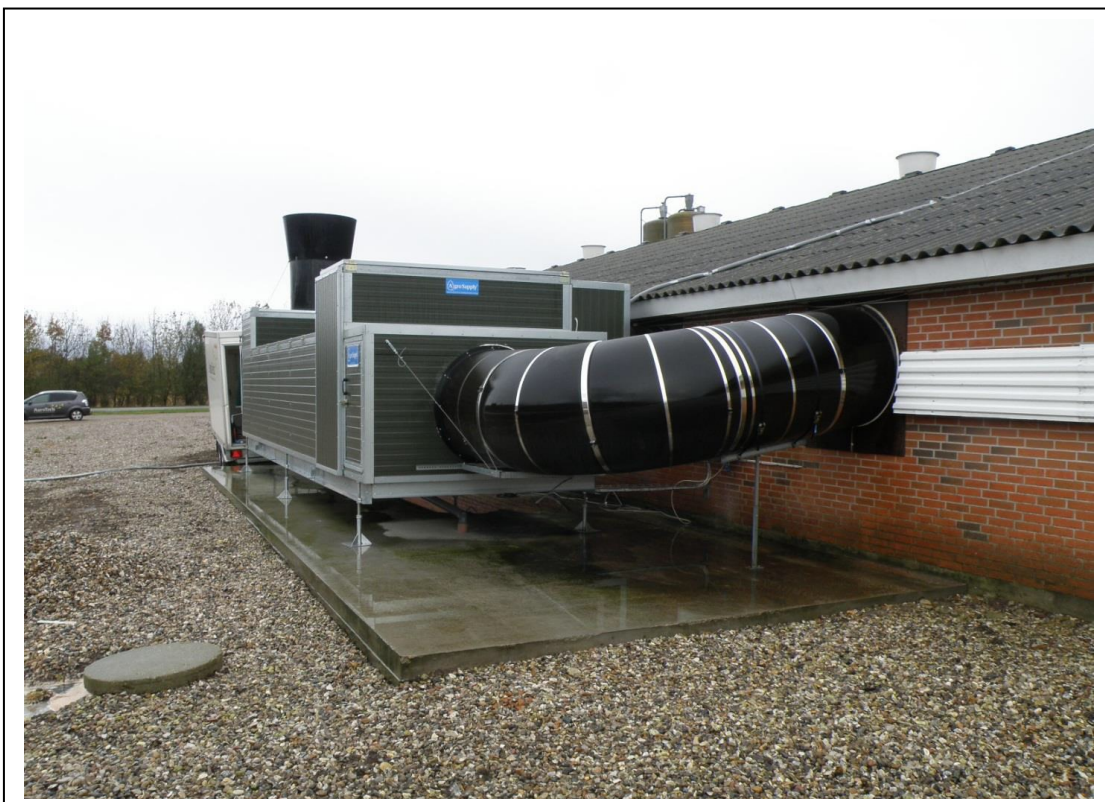
FIGUR 5 BILLEDE AF VARMEVEKSLER AF DEN TYPE DER INSTALLERES PÅ HUSDYRBRUGET LENDUMVEJ 86
