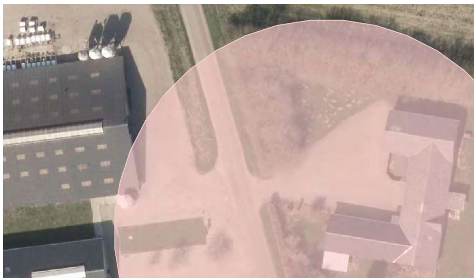
Fig. 4: Del af stalden der skal afgrænses med mur til kip.
