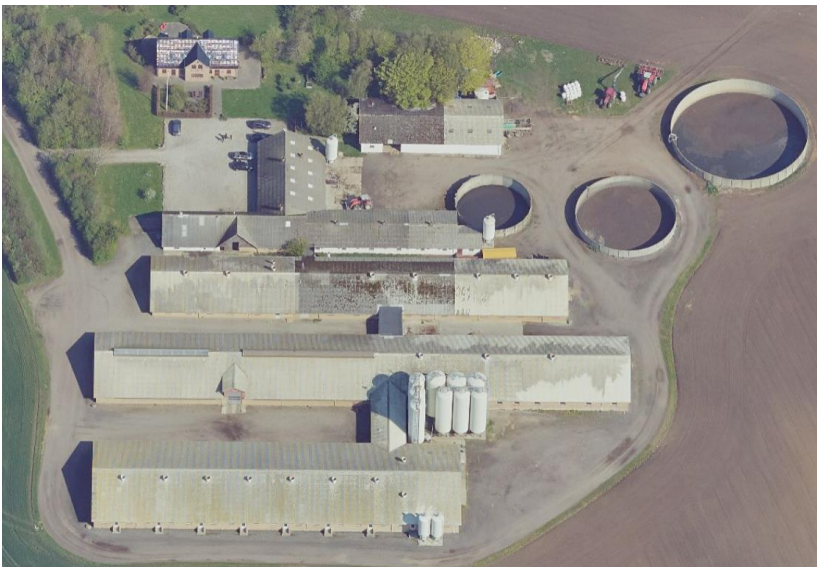
Figur 2: Højrupvej 37 set fra syd. Kilde Skråfoto.dk
