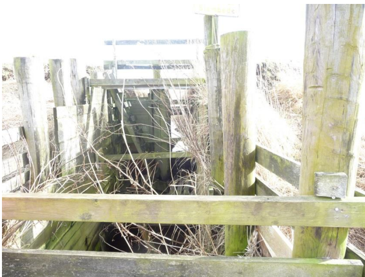
Foto 6: Sluse, der er halvt åben til højre.
