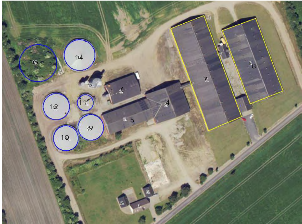
Fig. 1: Oversigt over ejendommen Gyvelvej 32
