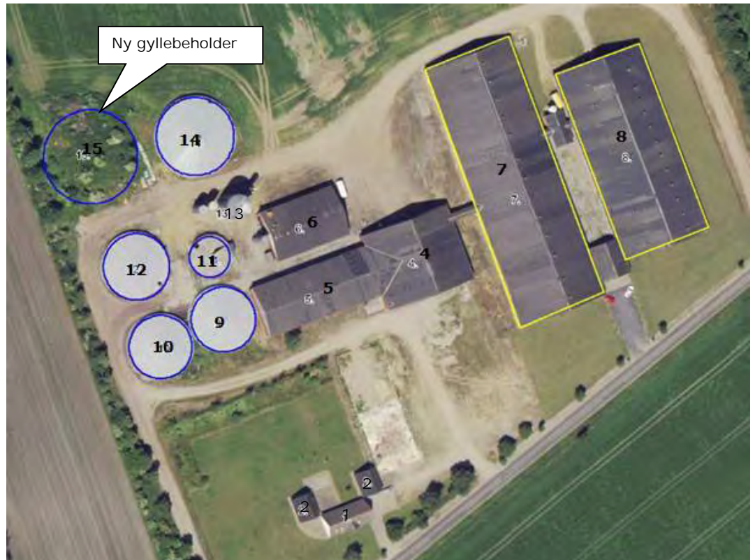
Fig. 2: Oversigt over ejendommen
