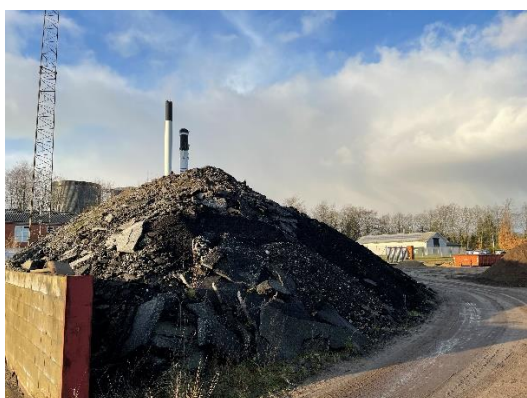
Opbrudt asfalt, der ikke kan knuses pt.
