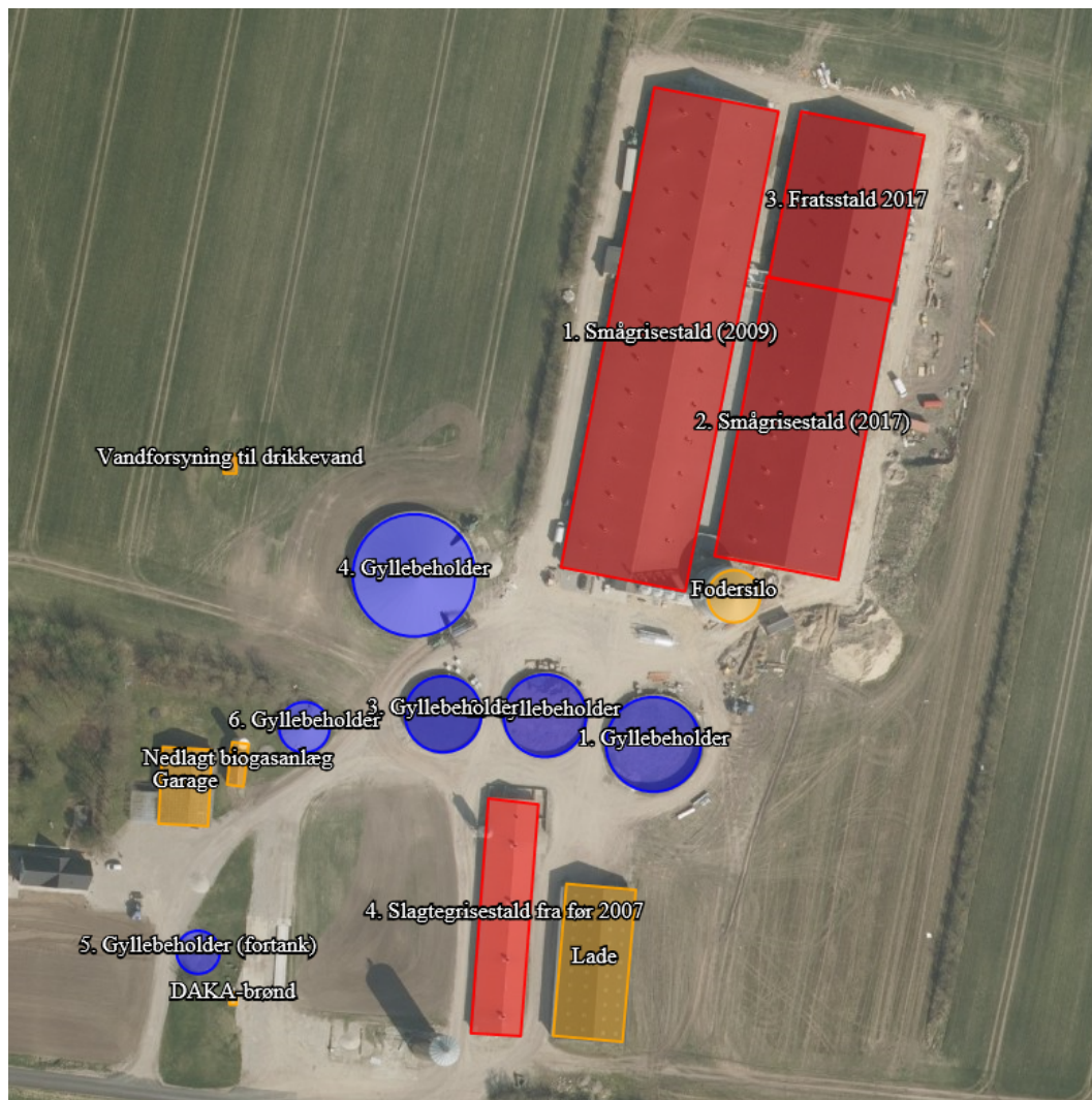
Figur 1: Oversigt over anlægget
