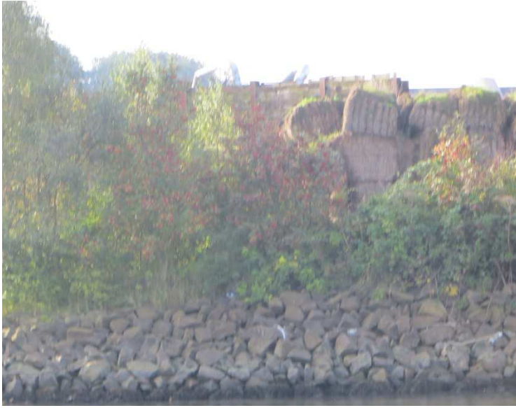
Udsnit fra støjvæggen bygget af halmballer, de vestligste del ind mod Fjernvarme Fyn
