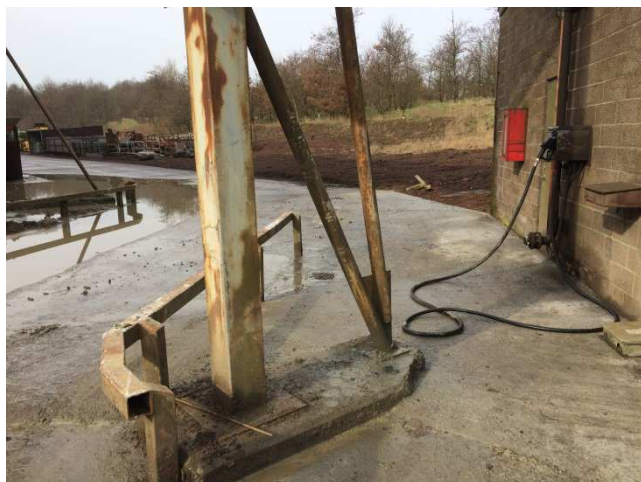
Foto 1: Ny belægning på dieselstanderplads. Desuden er der etableret olieudskiller i tilknytning til afløbet.
