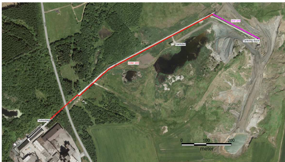
Foto 3: Olierørledningen fra fabriksområdet til råstofgraven
