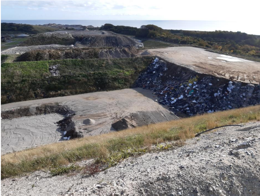
Asbestaffald på Etape II – uafdækket på tipfronter
