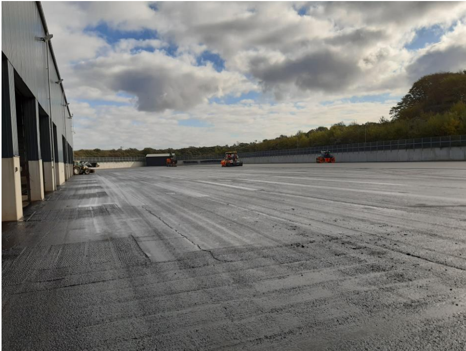
Ny-asfalteret areal ved omlaste-/sorterehal
