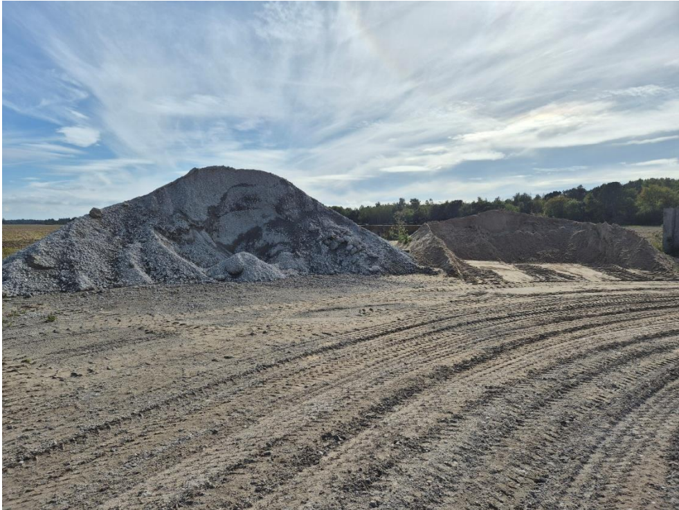
Figur 5. Oplag af knust beton. Der knuses ikke på pladsen. Det knuste beton er tilkørt.
