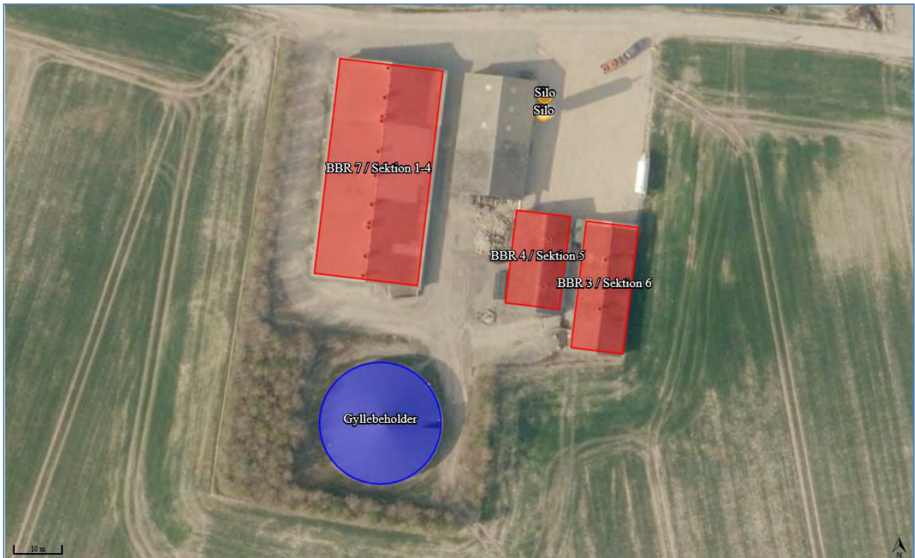
Figur 1: Husdyrbrugets stalde, opbevaringsanlæg mv. Foto: husdyrgodkendelse.dk
