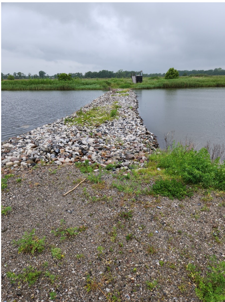
Foto nr. 6, foran stendige og udløbsbygværk.
