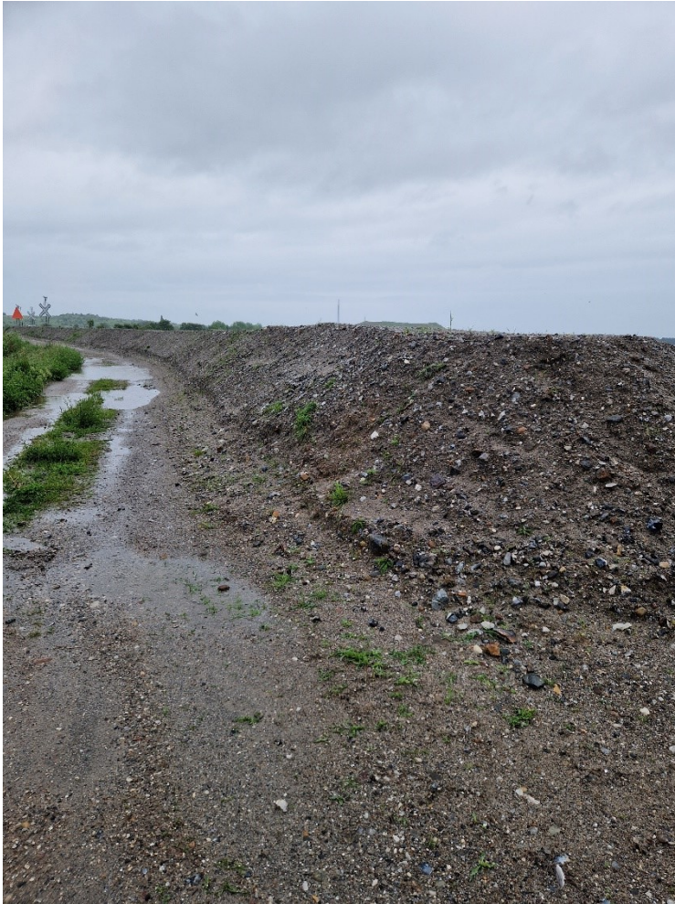
Foto 3. Yderside af det ny forhøjede dige.
