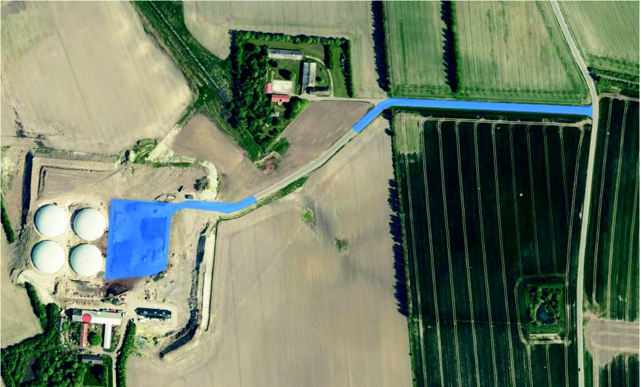
Kort visende det område, hvor der er udlagt slagger under asfalt. Den blå markering viser området, hvor slagger er udlagt.
