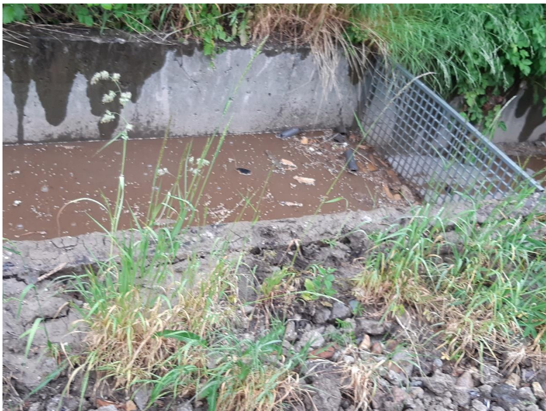
Afløbsbassin overfladevand fra plads til brændbart og træ
