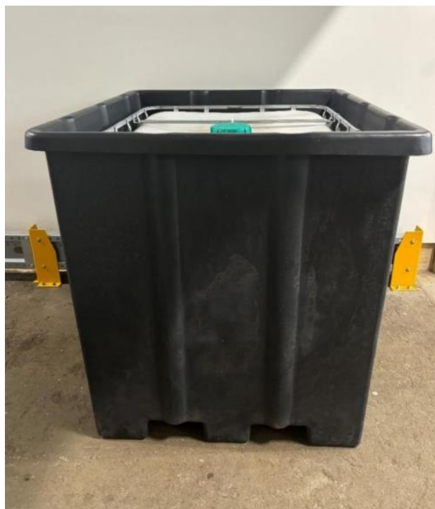
Avista Oil spildolietank med opsamlingskar
