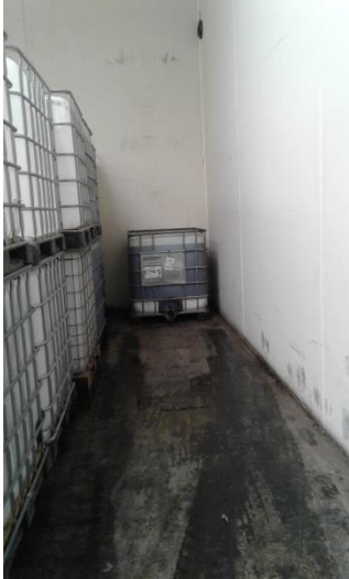
Billede 1 – oplag af olie, afløb til sump er udenfor billedet.
