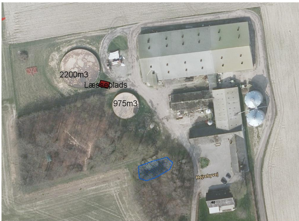
Luft foto 2.3.3. Gyllebeholdere på Bøgelund og læsseplads til gyllevogn
