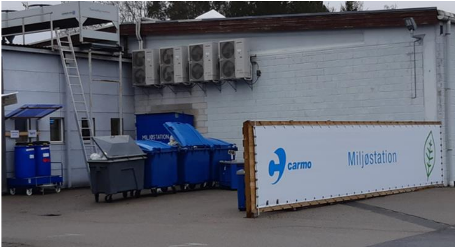
Miljøstation til plast m.m. Spildbakke og skab til farligt affald ses i baggrund.
