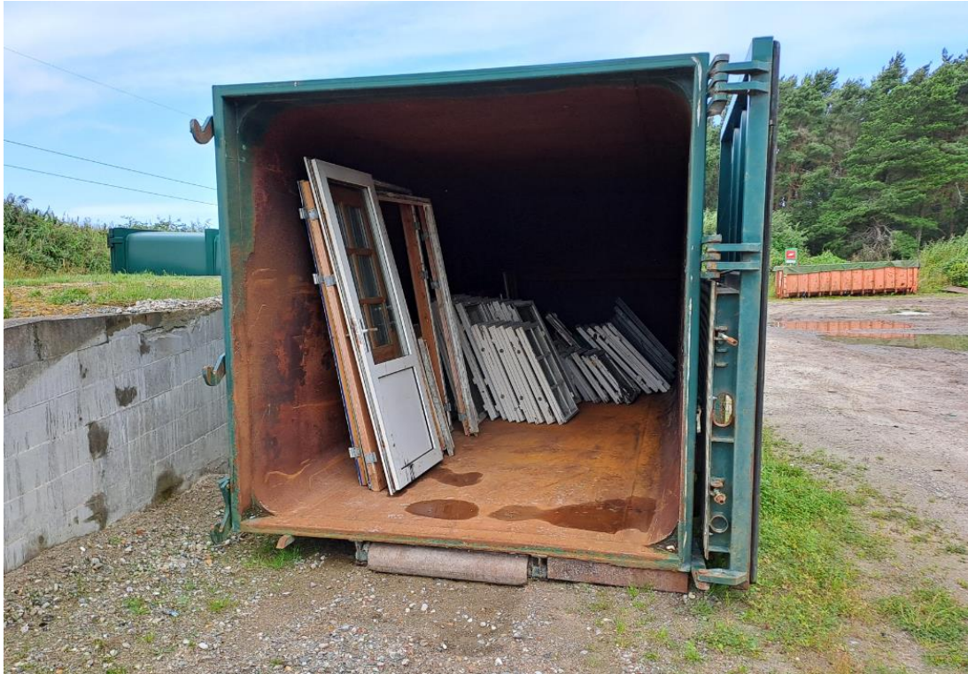
Figur 3. Container til vinduer, der kan indeholde PCB, opstillet på ubefæstet areal.
