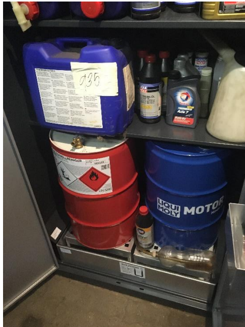
Kemikalieopbevaring i miljøskab med spildsikring.
